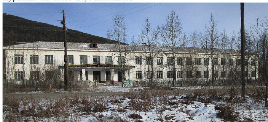
Здание бывшей школы п. Бурхала, 2025 г.
