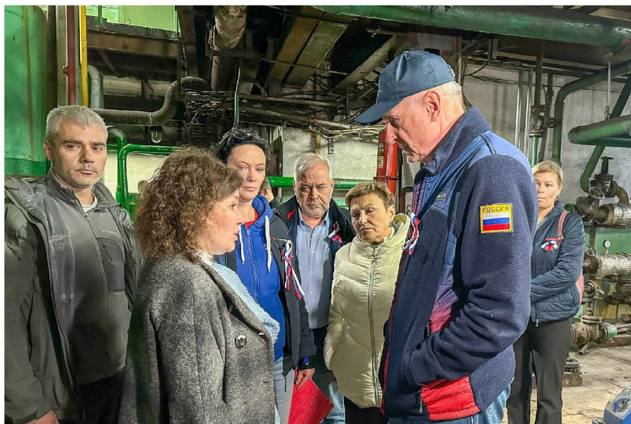
Руководитель филиала ООО “Теплосеть” - “Ягодное” И.И. Королёва докладывает губернатору о готовности котельной к отопительному сезону
